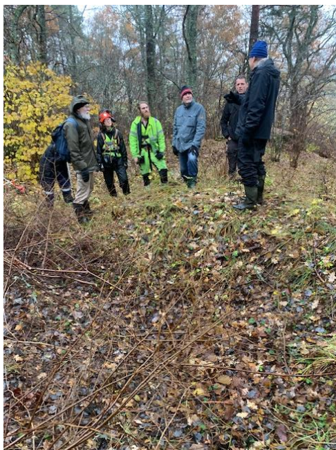
Inspektion av røjningen i nov 2023
